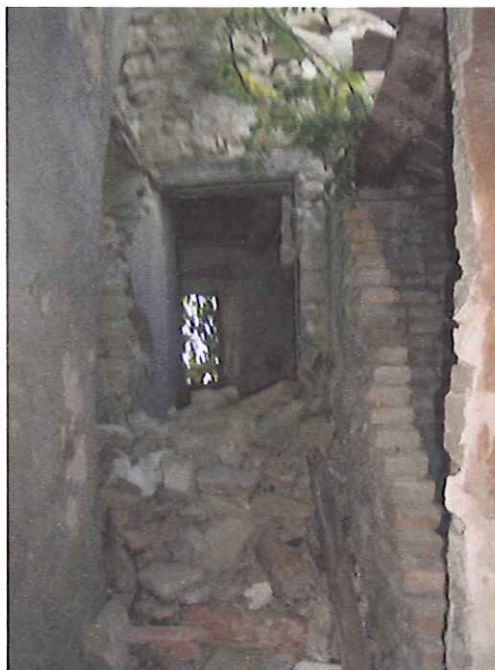
Fotografia n.5 – Ingresso della canonica oltre la porta di cui alla fotografia n.4
