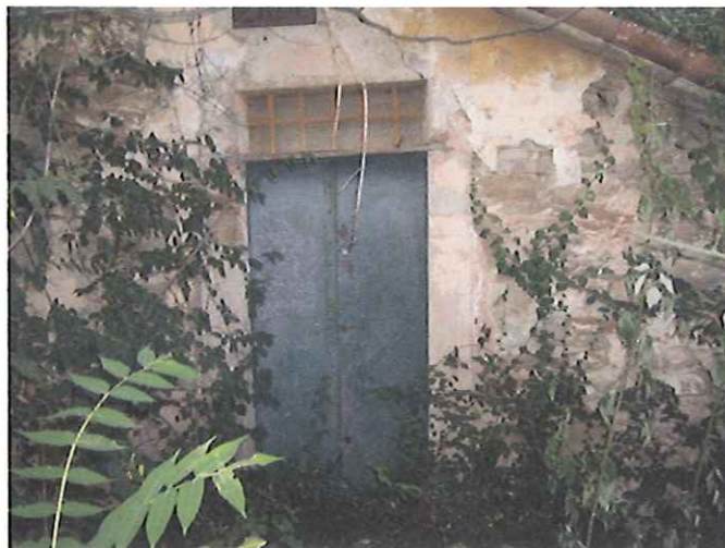
Fotografia n.4 – Ingresso alla canonica posto sul retro della chiesa
